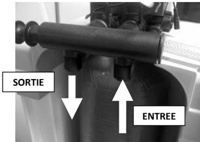
NB: Choisir des raccords en fonction de la canalisation utilisée (diamètre et matériau).
